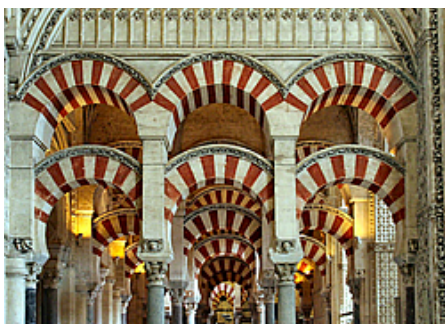
Fig 12: Arcos de medio punto (arco superior) y de herradura (arco inferior) de la mezquita de Córdoba.
