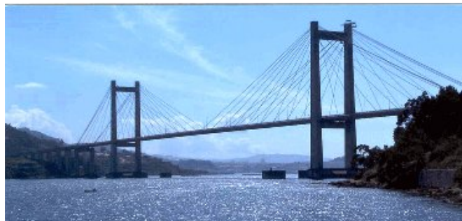
Fig 15: Puente de Rande sobre la ría de Vigo.
